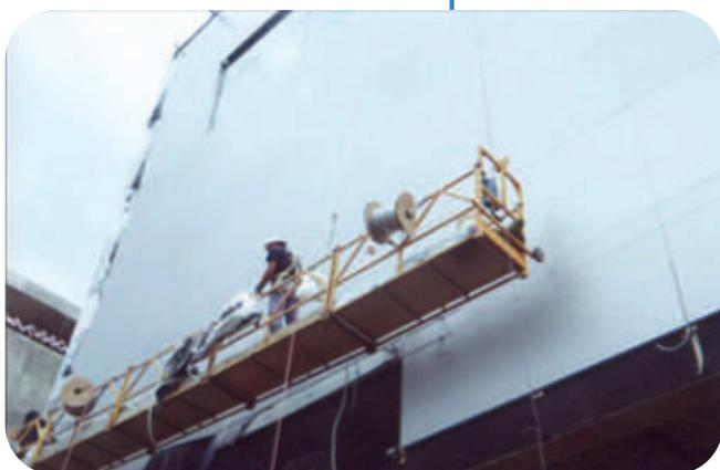
Las plataformas de trabajo deberán cargarse únicamente con el material necesario para realizar los trabajos, debiendo repartirse el mismo de forma uniforme por toda ella para evitar basculamientos y retirar los escombros con sistemas de tolvas o similar. En ningún caso deberá sobrecargarse la plataforma de personas o material, teniendo en cuenta su carga nominal.
