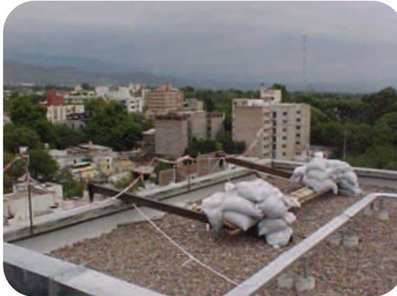
Los parantes de apoyo deberán estar derechos y apoyarse en terreno firme, o en su defecto sobre una tabla horizontal de largo y ancho suficientemente resistente.
