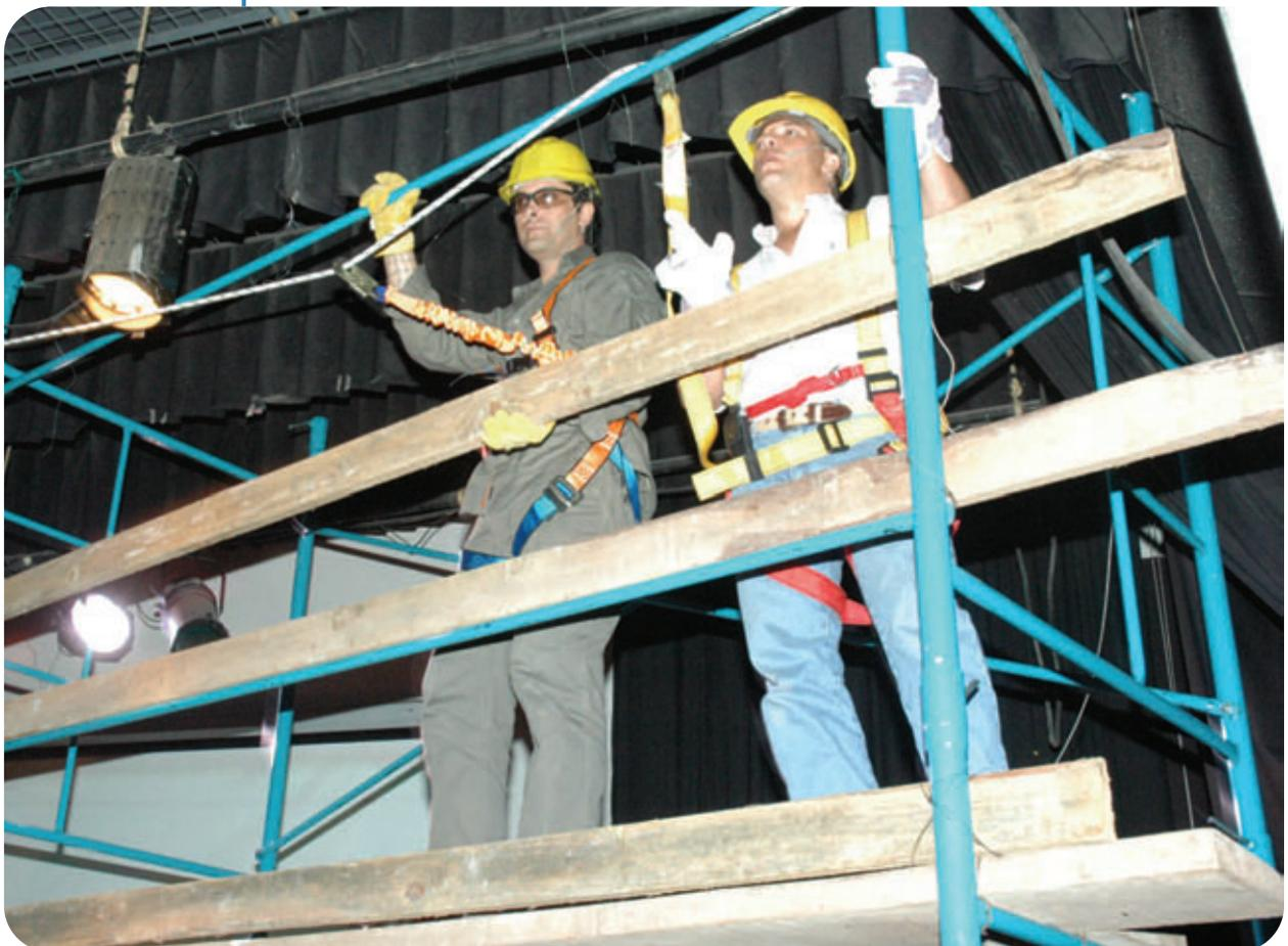
Los tablonces que conformen la plataforma deben estar trabados y amarrados sólidamente a la estructura del andamio, sin utilizar clavos y de modo tal que no puedan separarse transversalmente, ni de sus puntos de apoyo, ni deslizarse accidentalmente. Ningún tablón que forme parte de una plataforma debe sobrepasar su soporte extremo en más de veinte (20) centímetros.
