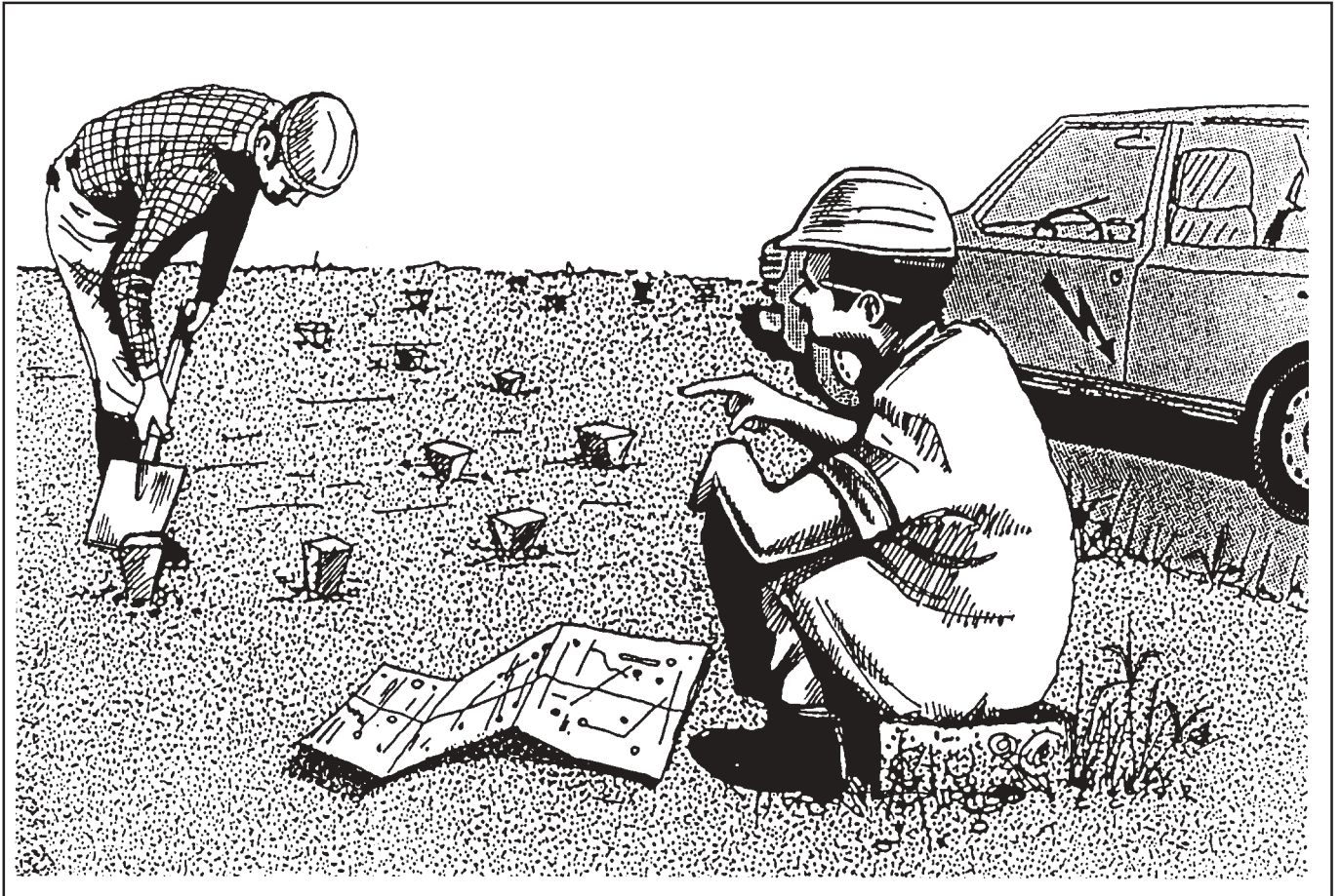
Figura 12. Localización de cables eléctricos enterrados, según un plano, y marcado de su posición.
