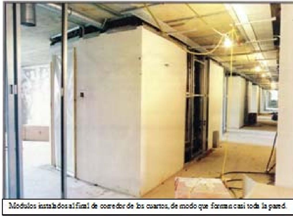
Cuando llegan al edificio en construcción, se elevan a una plataforma en el piso correspondiente mediante una grúa, y se desplazan por el corredor en un carro especial. Esta operación está bien planificada y tiene un muy buen historial de seguridad.
