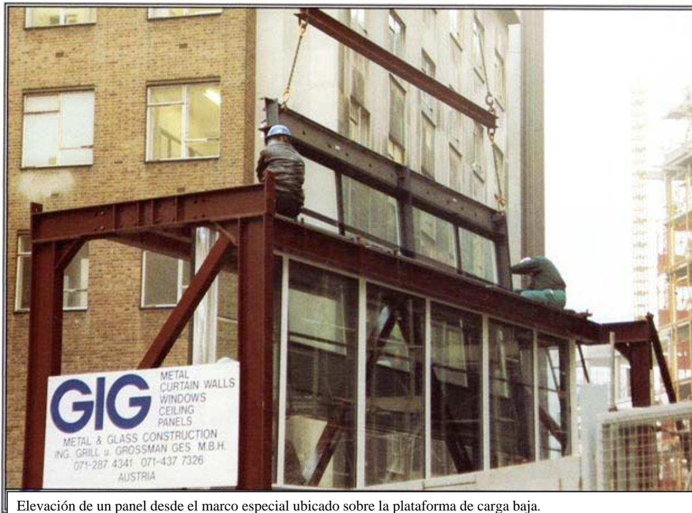
Elevación de un panel desde el marco especial ubicado sobre la plataforma de carga baja.
